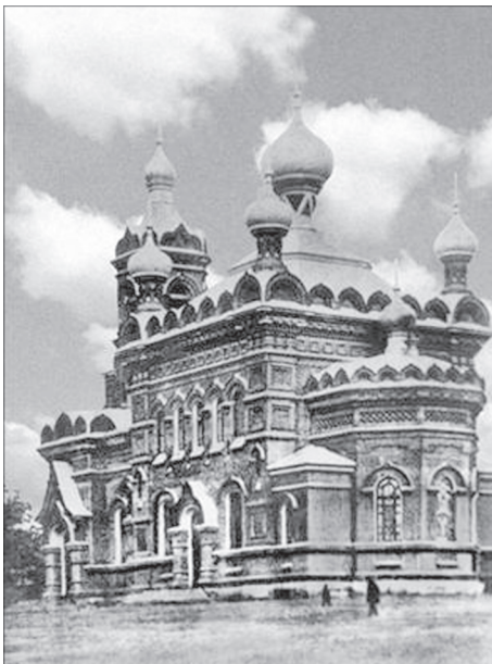
Покровская старообрядческая церковь в Хвалынске. Дореволюционный вид
